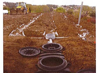
Réalisation d'un chantier par «tranchée d'épandage»
